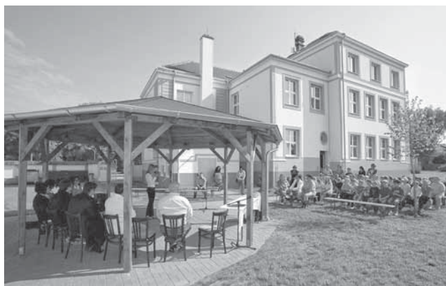
ŠKOLE TO SLUŠÍ. Budově základní školy to ve zbrusu novém „kábátě“ sluší. Radost všem udělal i nový výukový pavilon. Foto: František Havlík
