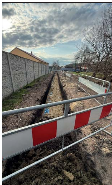
Vodovod a kanalizace v ulici U rybníka
