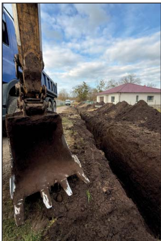
Vykop pro vodovod v ulici U rybníka
